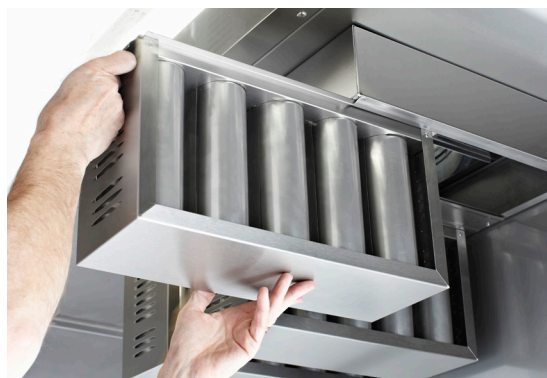
Filterkassetten skubbes ind i filterhuset.
